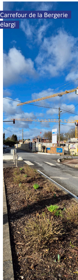
Travaux pluri-annuels de voiries
